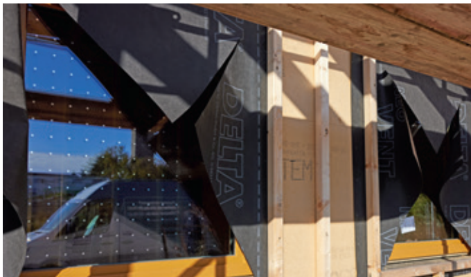
Oben: Metallische Punkte machen das Glas für Vögel sichtbar.
