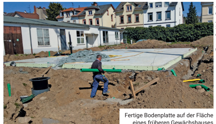
Baustellenführung am 22. April 2022
