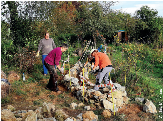
Anlage der Trockenmauer auf dem Biotopgrundstück
